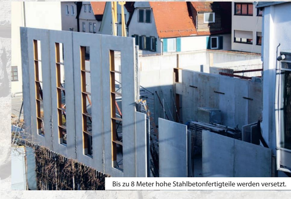
Bis zu 8 Meter hohe Stahlbetonfertigteile werden versetzt.
