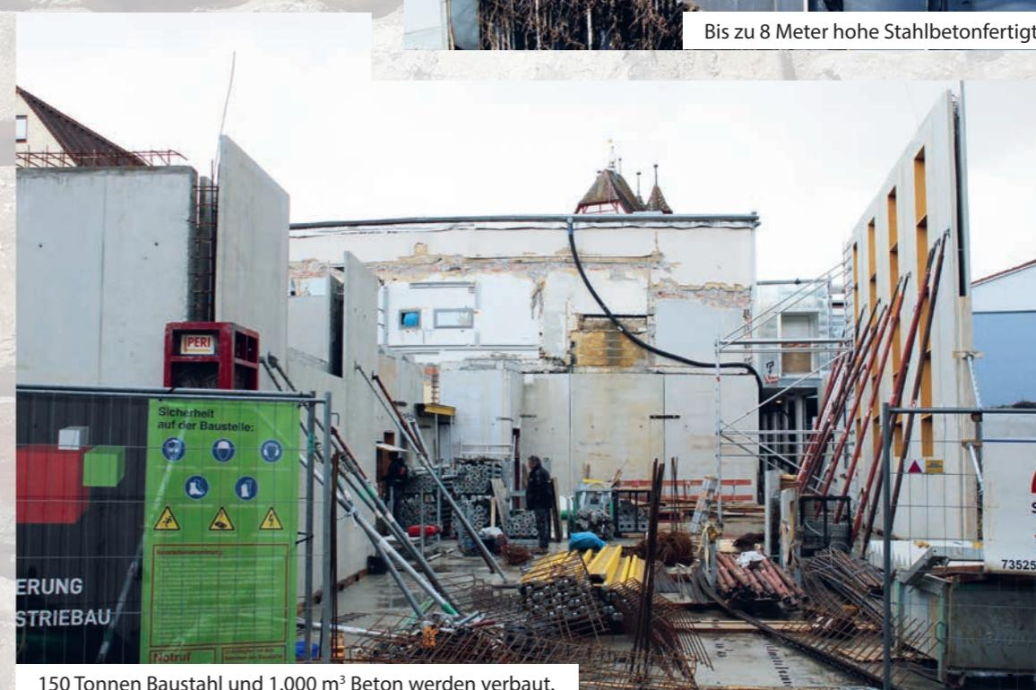
150 Tonnen Baustahl und 1.000 m<sup>3</sup> Beton werden verbaut.
